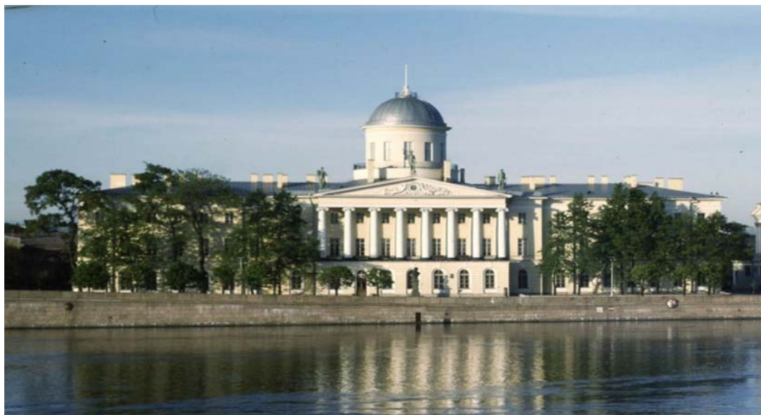
Рис. 2. Здание главной Морской таможни в Санкт-Петербурге
